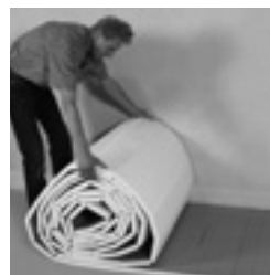
2. Rozložit a rozvinout systémové prvky CosmoROLL
