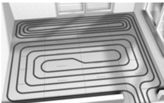
Obr. 4: Spirálovitý způsob pokládky s oddělenou okrajovou zónou
