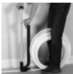
6. ... patentních sponek upevnit k systémovým prvkům
