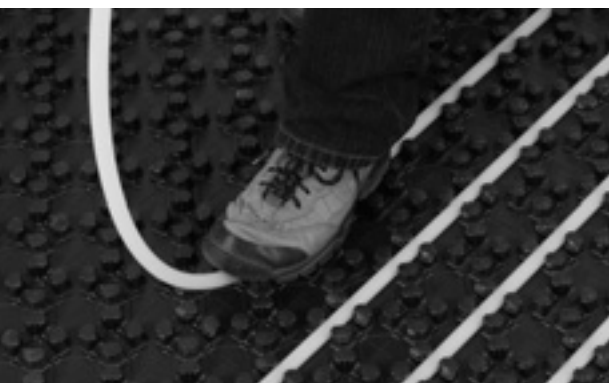
Pokládka topné trubky do desky s výstupky CosmoTEC
