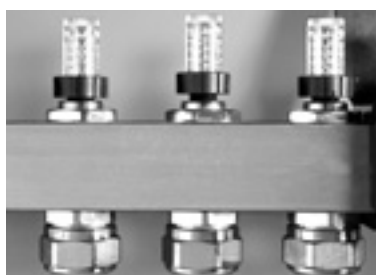
Obr. 2 Zpátečka – zabudované kompenzátory
