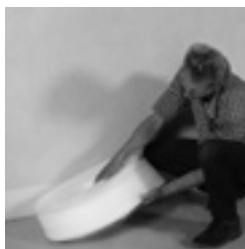
1. Položit okrajový izolační pás s postranním lemem s fólie
