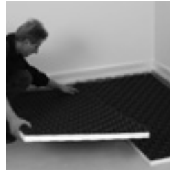
3. Poskládat desky s výstupky CosmoTEC
