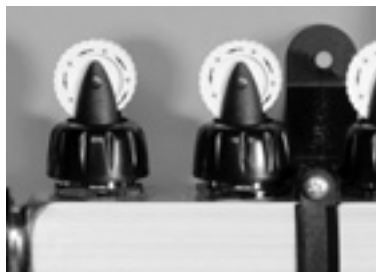
Obr. 1 Přívod – zabudované ruční stavěcí ventily
