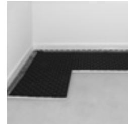
4. Odříznutými částmi prvků začínat další řadu pokládky
